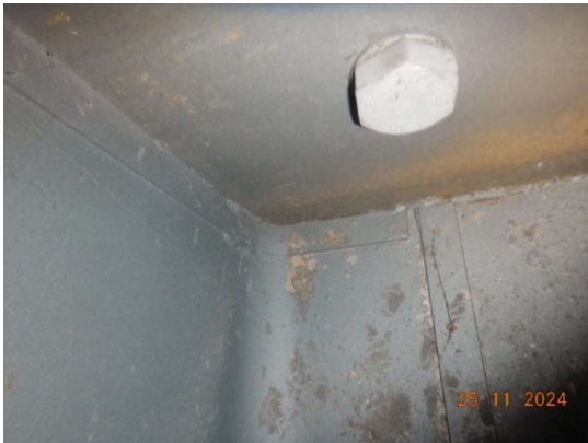
SCHWEIßNAHT UNTERBROCHEN
