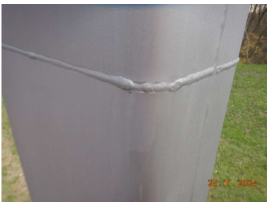
SCHWEIßNAHT MIT UNREGELMÄßIGKEITEN
