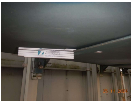
FLACHSTAHL LIEGT NICHT VOLLSTÄNDIG
