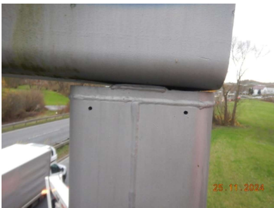
STIEL BOHRUNG NICHT VERSCHLOSSEN_
