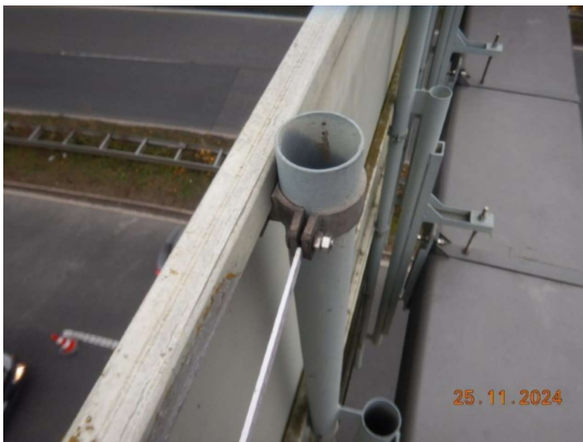
ANSCHLUSS KLEMMSCHELLE LOSE
