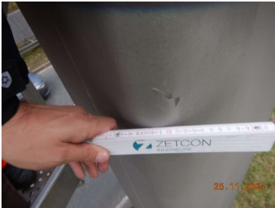
KORROSIONSSCHUTZSCHÄDEN
