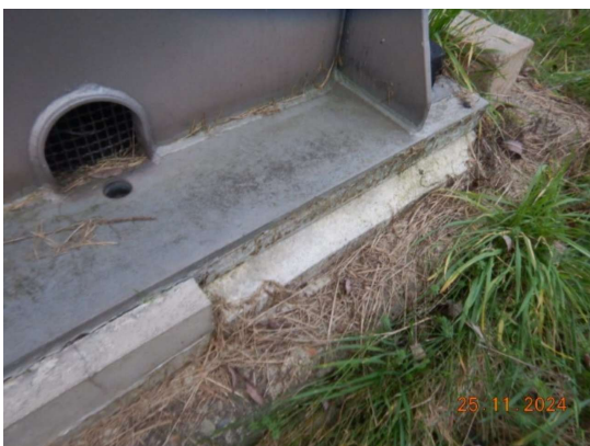
UNTERFUGEN ABGEPLATZT
