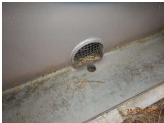
EINFÜLLLOCH NICHT VERSCHLOSSEN
